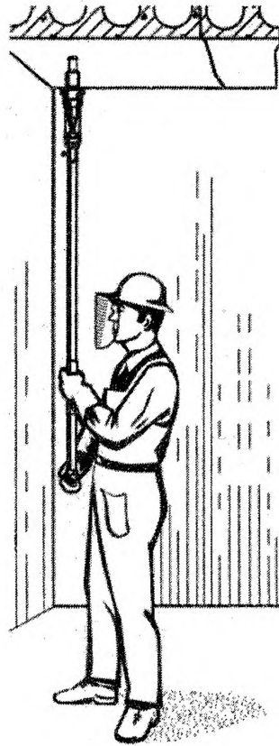
Рис. 4.12. Пробивання отвору в плиті перекриття приміщення за допомогою колонки КК-2М
