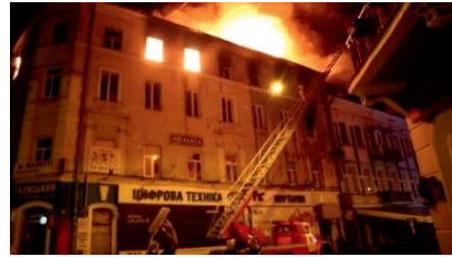
Іл. 41.5. Пожежа в центрі Тернополя в 2015 р.
