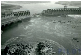
Іл. 40.8. Зруйнована вибухом гребля Дніпрогесу в 1941 р.
